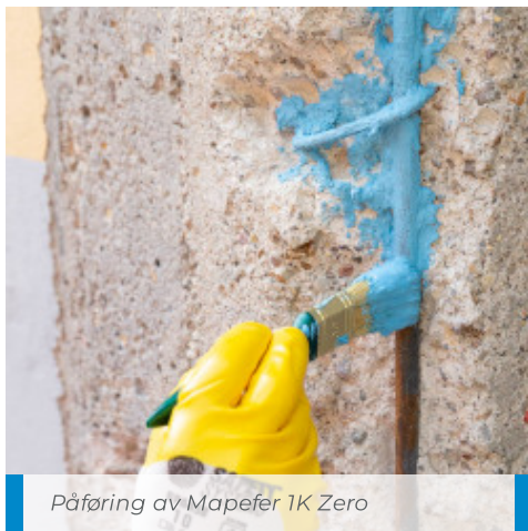
Påføring av Mapefer 1K Zero på armeringen til en viadukt
