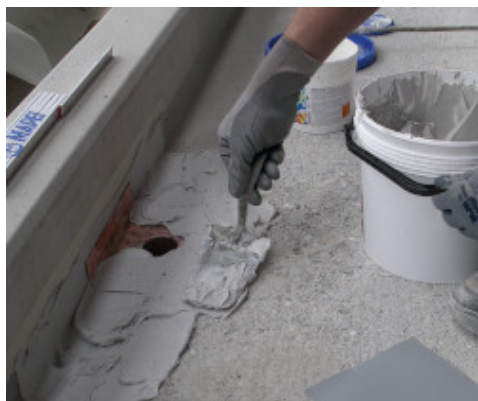
Skarvarna utjämnas med Adesilex PG4
