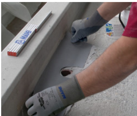
Hypalonmembranet sätts på plats
