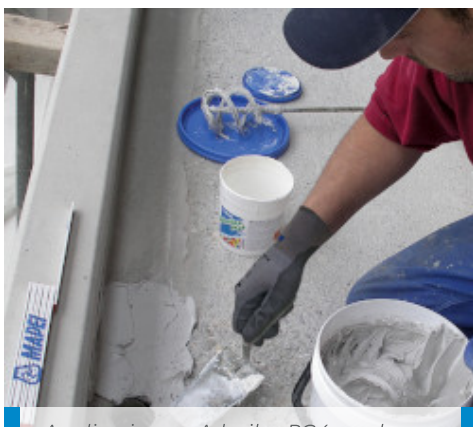
Applicering av Adesilex PG4 med spackel
