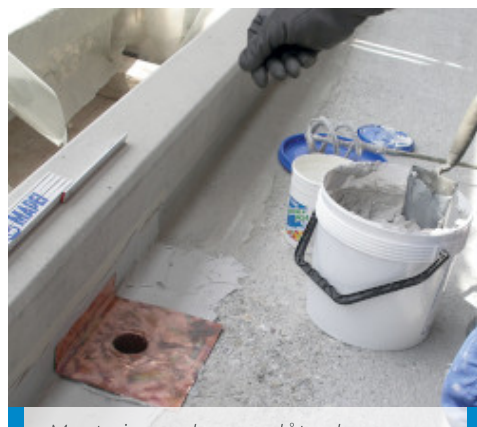
Montering av kopparplåt och golvbrunn
