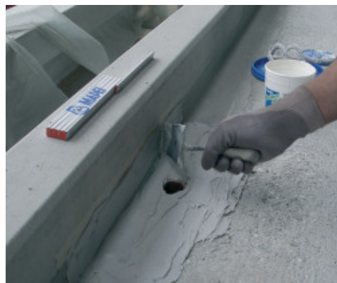
Slutfinish med Adesilex PG 4
